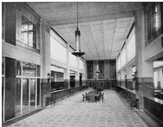
Рис. 15. Вид на операционный зал Азовско-Донского банка со стороны входа (1907 г.), Ф.И. Лидваль;
