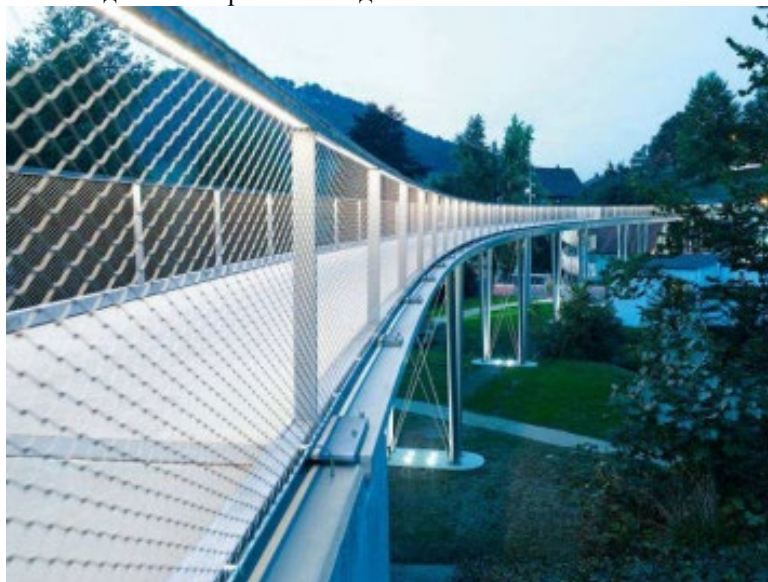
Рис. 6. Пешеходный мост в г. Албшадт [1]
