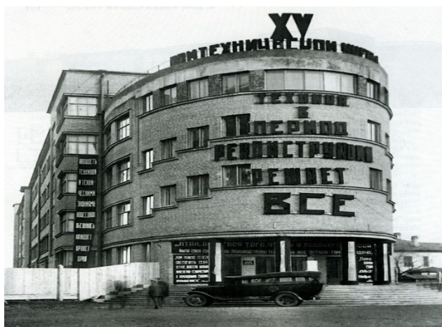
Рис. 3. Дом технической учёбы, 1930 – 1932 гг., пл. Ивана Черных, 4.
