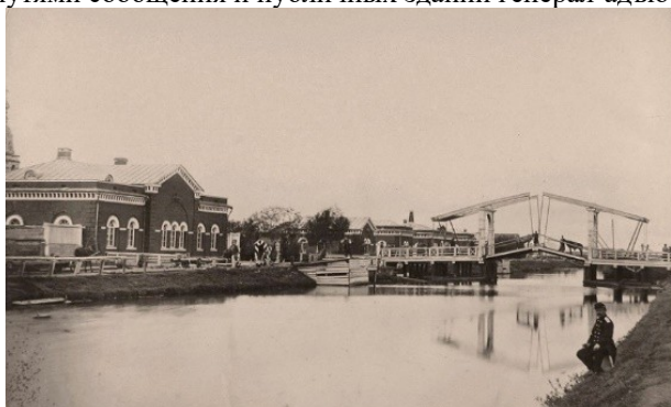
Рис. 20. Подъемный мост на Белозерском канале. 1865 год. Источник: группа «ВКонтакте» «Белозерская старина»
