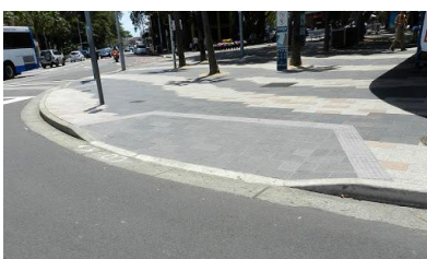
Рис.4 Хороший пример устройства съезда с тротуара
