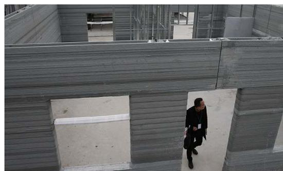
Рис.6. Напечатанные блоки для зданий. Выставка в технопарке китайской провинции Цзянсу
