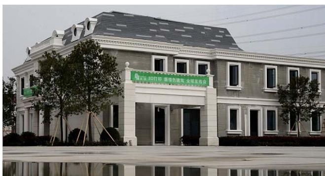
Рис.5. 2-х этажное здание напечатанное с помощью 3D - принтера
