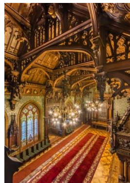
Рис. 7. Свод из пяти килевидных арок в Готической столовой особняка Кельха (ул. Чайковского, 28)
